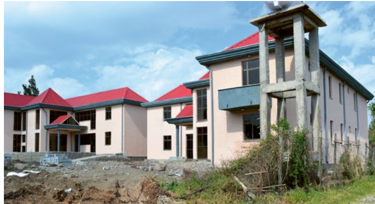
Neue Kinderhäuser von aussen...
