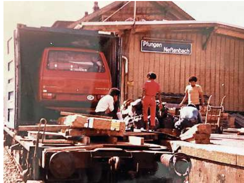
Der erste Container für SELAM wurde am Bahnhof Pfungen beladen.
