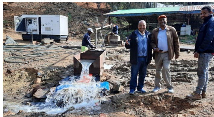
WASSER! V.l. Solomon Chali, Solomon Negash (Leiter Bauten und Unterhalt)
